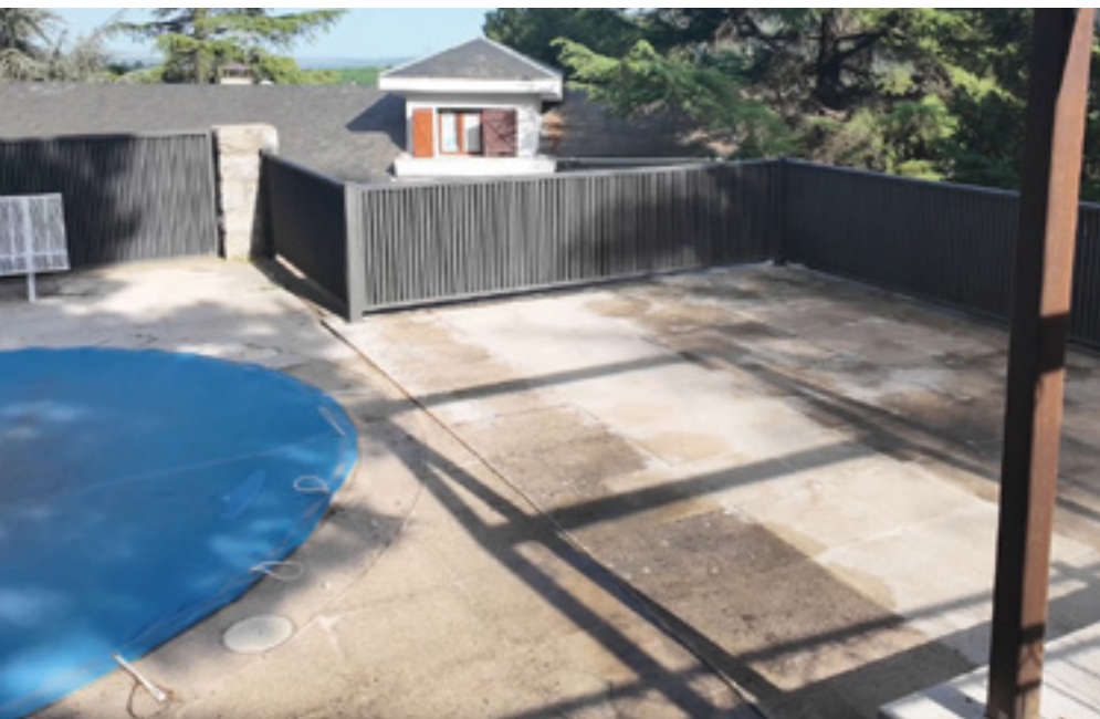
Resultado de la limpieza del pavimento exterior de la piscina con Excentr.
